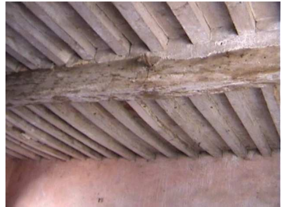
Frequenti i soffitti a travi
